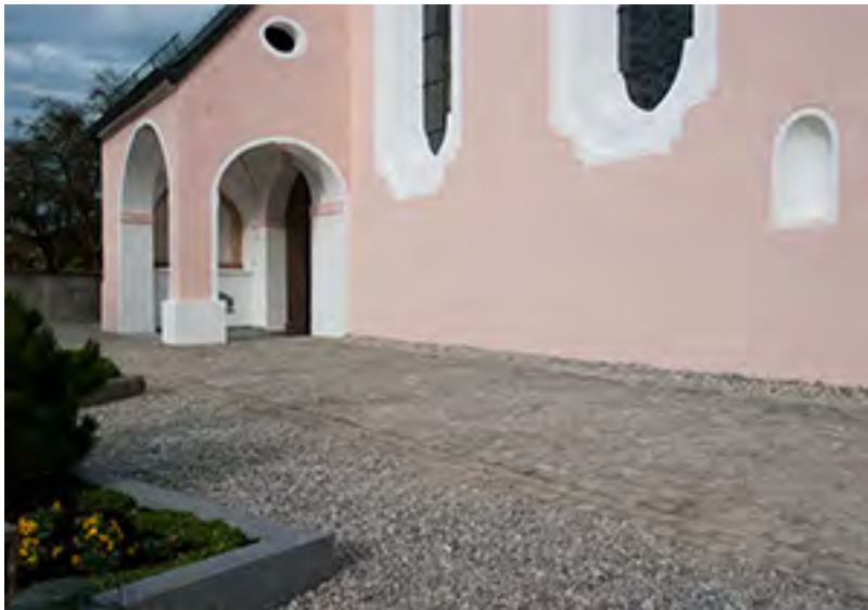
Der Weg zum Eingang wurde neu verlegt
